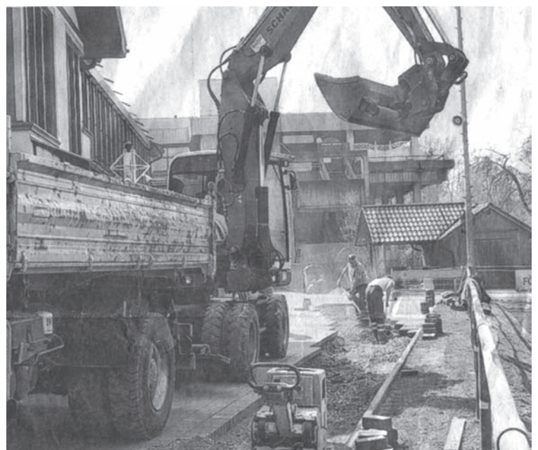
Hochbetrieb herrschte in den letzten Tagen auf dem Gehweg parallel zum Mellrichstädter Sportplatz, wo die Leitungen für den Anschluss des Bades an die Biogasanlage verlegt wurden. FOTO BOTT
