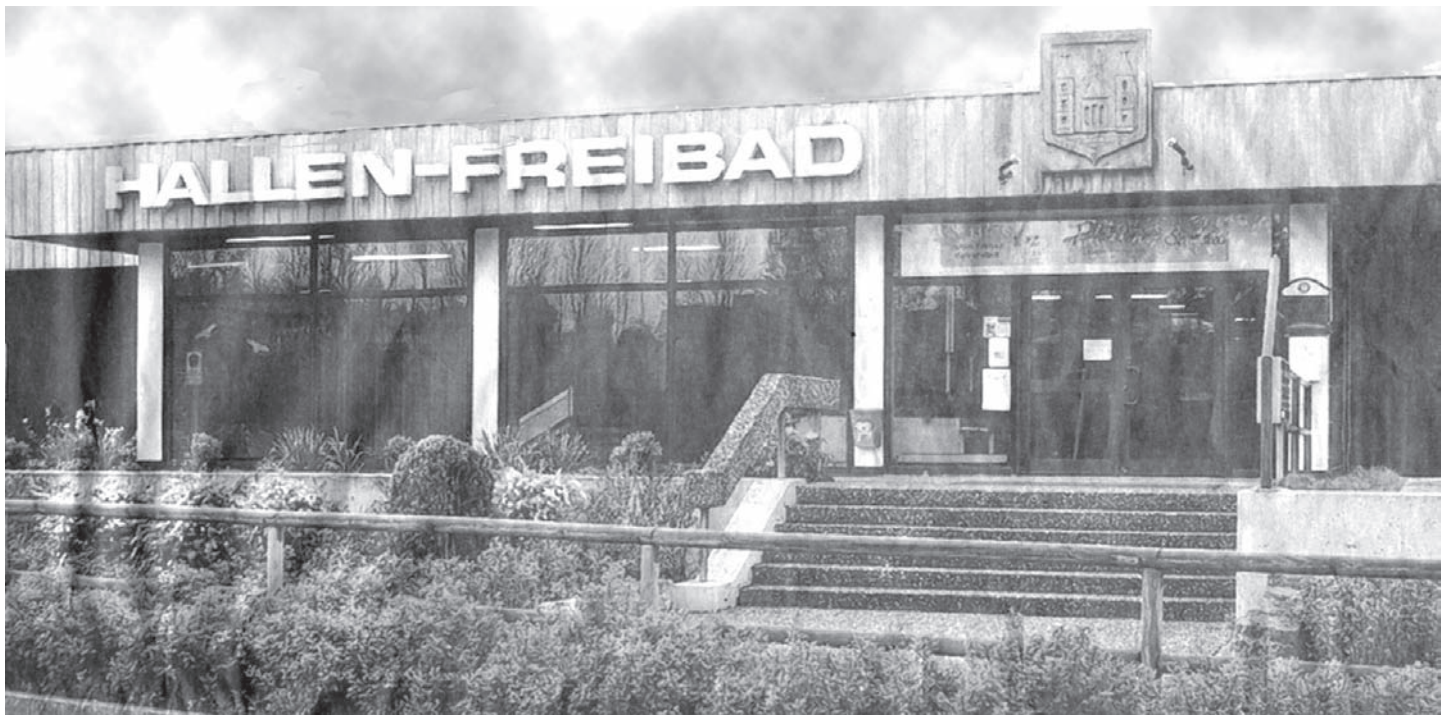
Künftig wird das Hallen-Freibad in Mellrichstadt mit Wärme aus der Biogasanlage beheizt, so können etliche Kosten eingespart und die Wassertemperatur erhöht werden. FOTO BOTT
